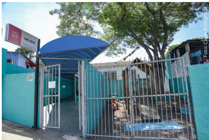
Entrada da EMEB Nelson Álvaro Figueiredo Britto
