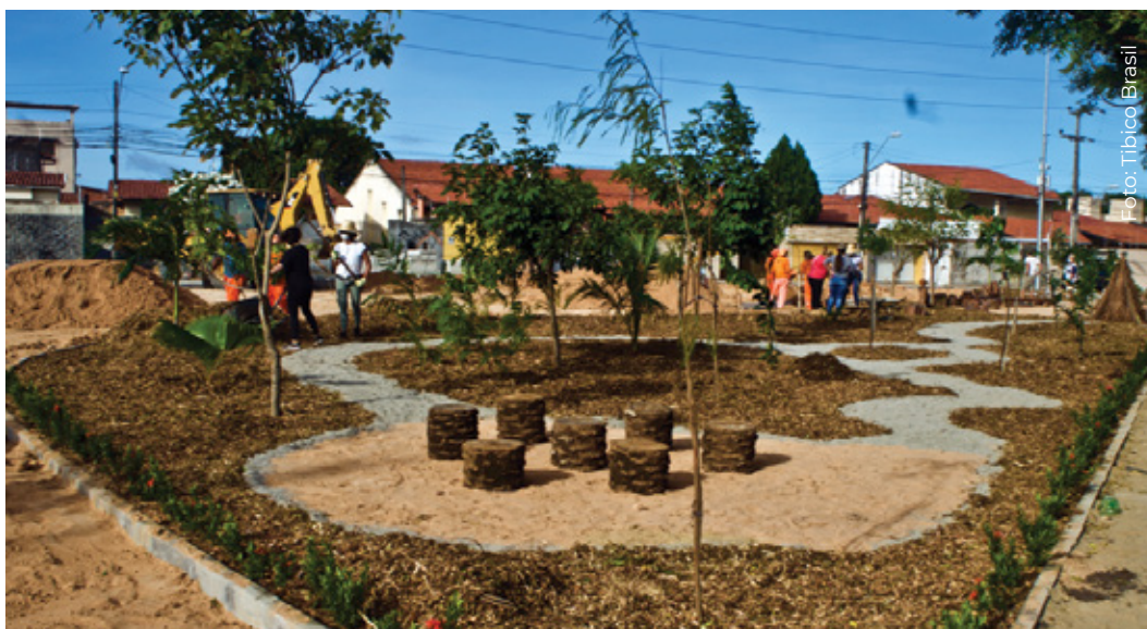
Construção de parquinho naturalizado em Fortaleza, CE
