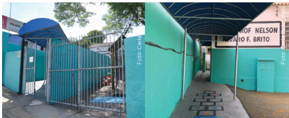
Fachada e entrada da EMEB Prof. Nelson Álvaro Ferreira Brito
