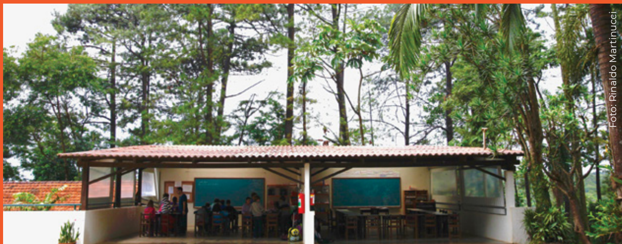
Estrutura arquitetônica das salas de aula da Escola Ágora em Cotia, SP
